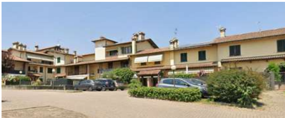
1 - facciata su strada
